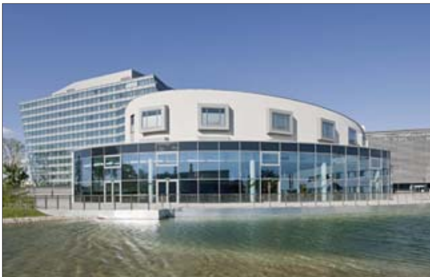
BGF Restaurant- und Konferenzbereich umfassen rund 8800 m 2
