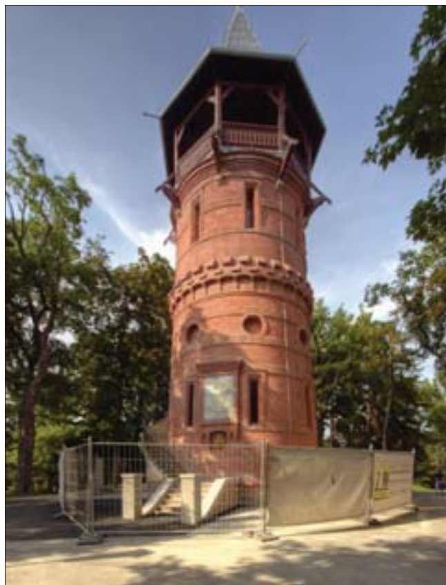
Der Aussichtsturm »Paulinenwarte« wird komplett saniert.
