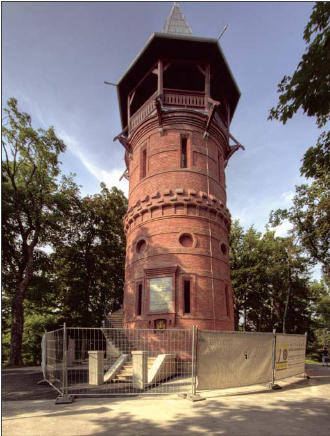
Der Aussichtsturm »Paulinenwarte« wird komplett saniert.
