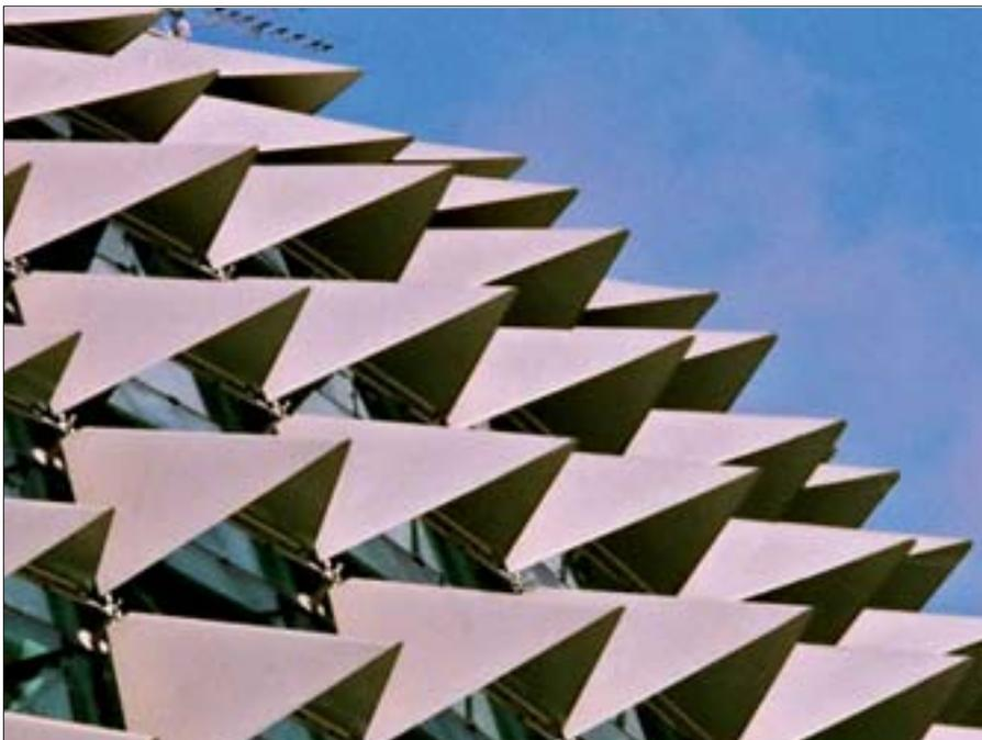
Mit TIGER Pulverlack beschichtete Fassadenelemente, wie hier verzinkte Stahlbauteile auf dem Kuppeldach des Esplanade Arts Center in Singapur, sind rund um den Globus zu finden.
