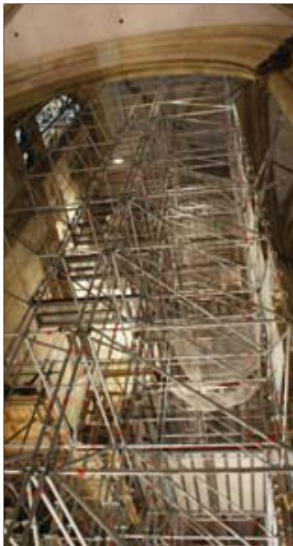
Das Montagegerüst reicht bis zur Decke
