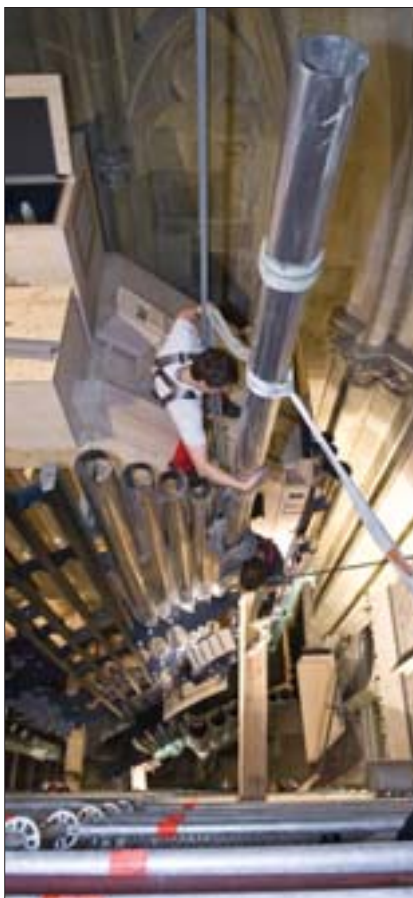
Arbeiten in schwindelnden Höhen
