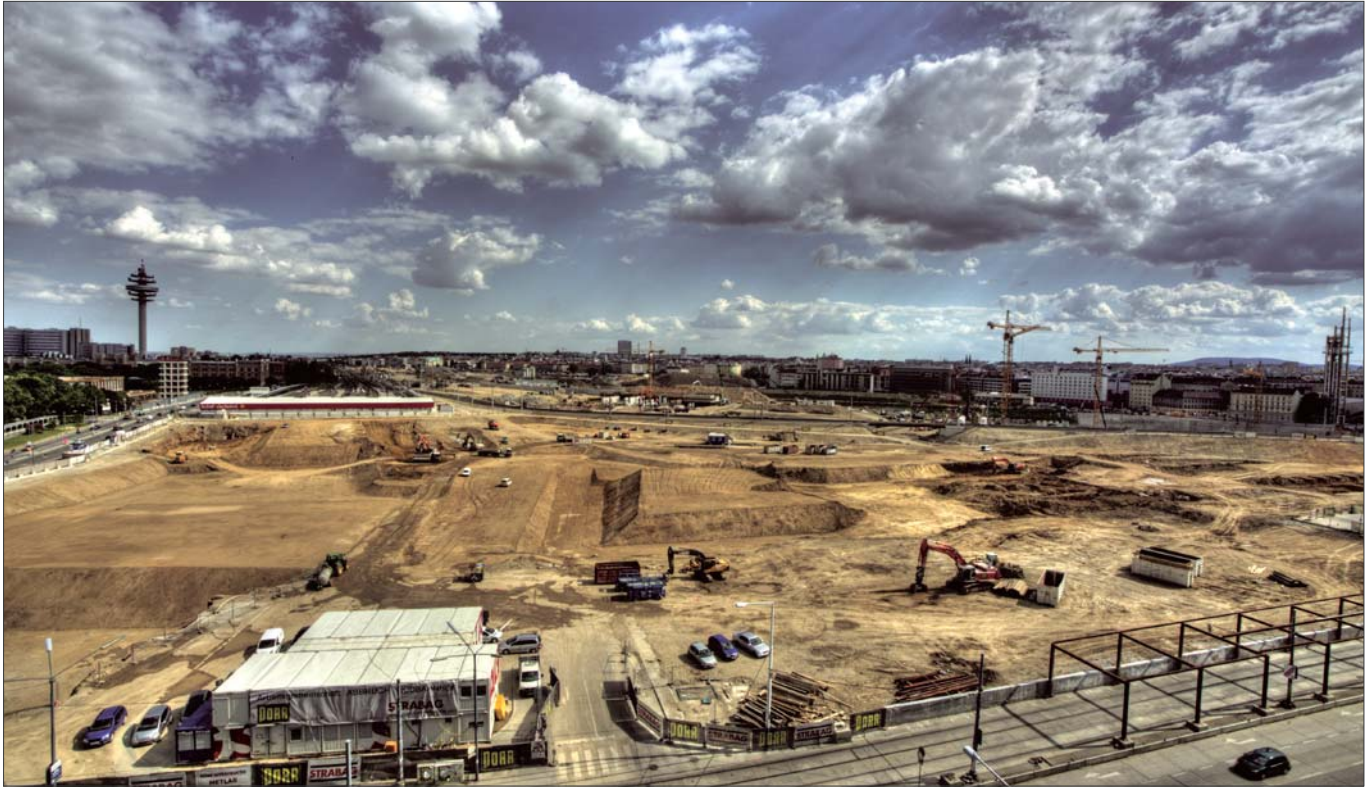
Das Gesamtprojekt Hauptbahnhof Wien mit einer Größe von 109 ha die größte Baustelle Österreichs. 2013/2014 wird mit der schrittweisen Inbetriebnahme der Verkehrsstation begonnen, 2015 soll der Vollbetrieb aufgenommen werden.
