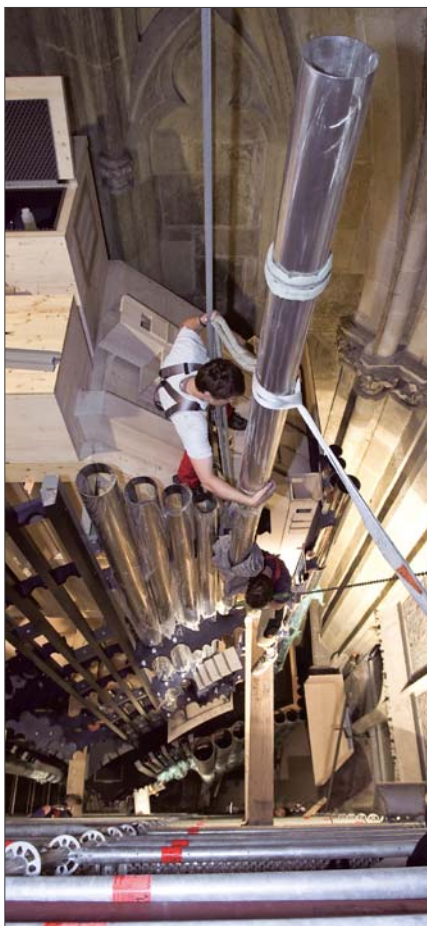
Arbeiten in schwindelnden Höhen
