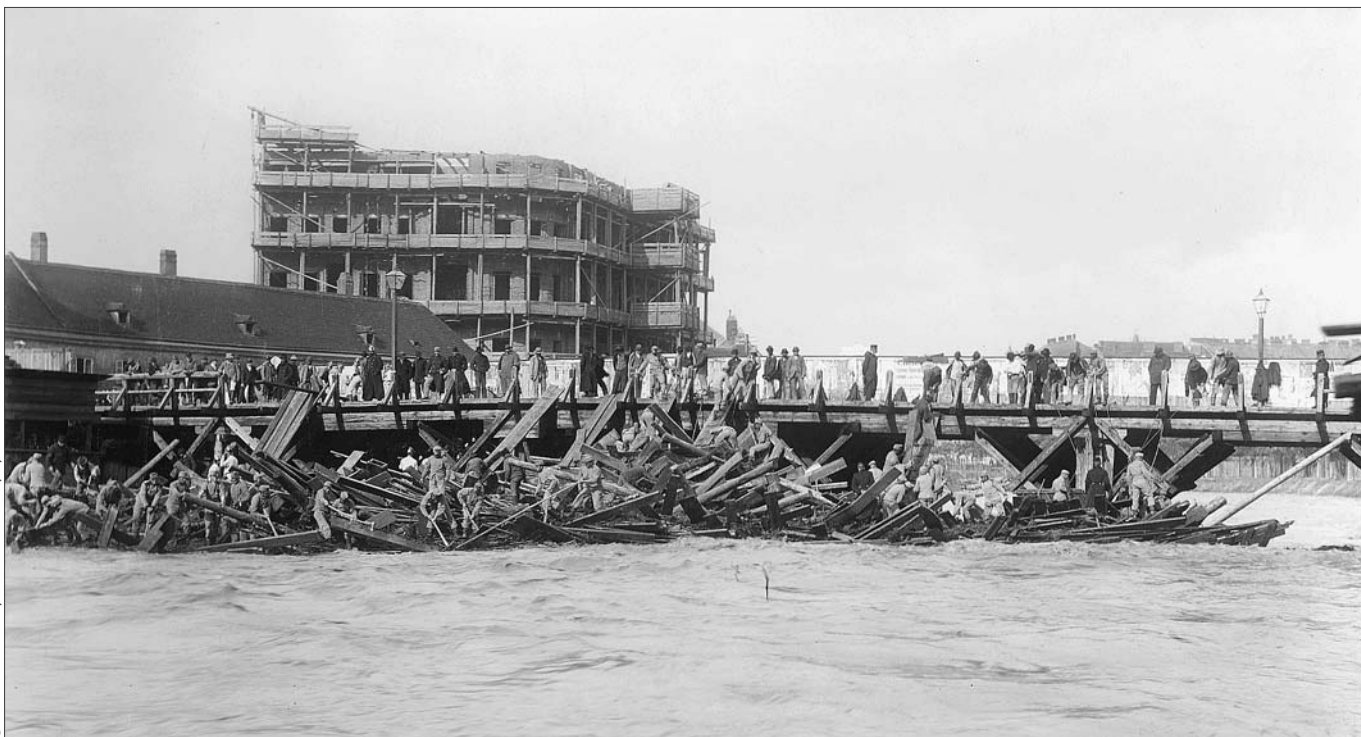
Dieses Foto vom Wien Museum zeigt wasserbauliche Arbeiten im Bereich der ehemaligen Kettenbrücke.
