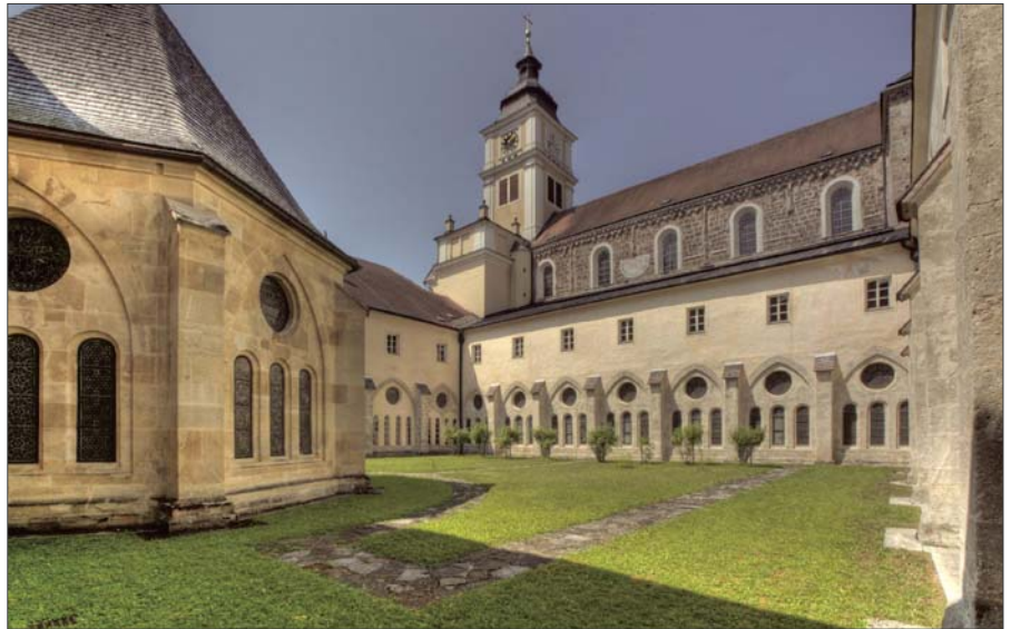
Blick auf den Kreuzgang und die Kirche, links im Bild sieht man das Brunnenhaus.
