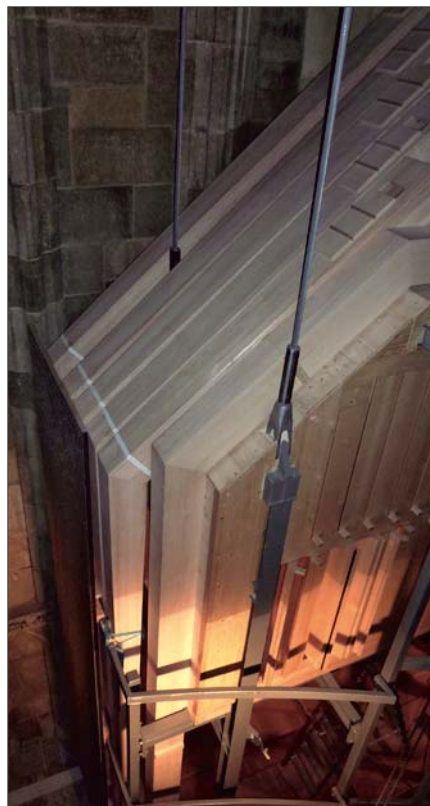
Aufhängekonstruktion und die längsten Pfeifen in Holz (10,5 Meter)
