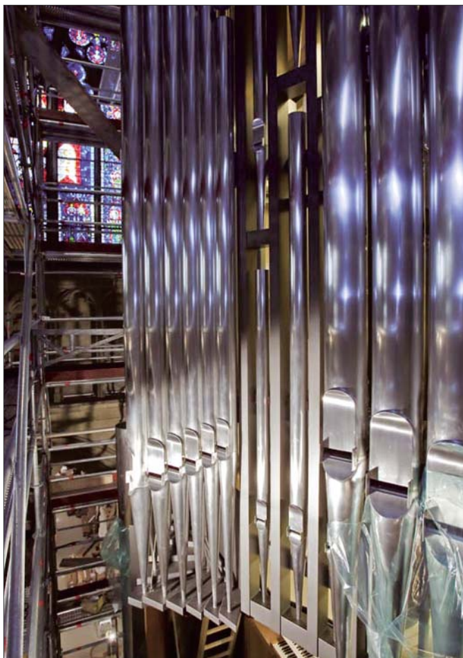
Viele hundert Orgelpfeifen müssen an der 18,3 m hohen ... und 7,7 m breiten Orgel montiert werden.
