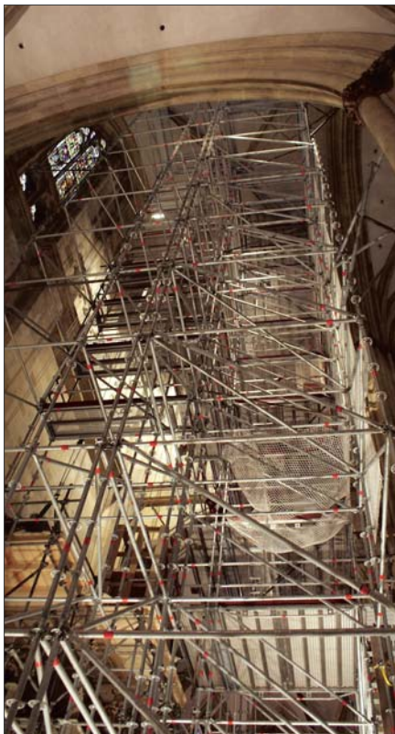
Das Montagegerüst reicht bis zur Decke
