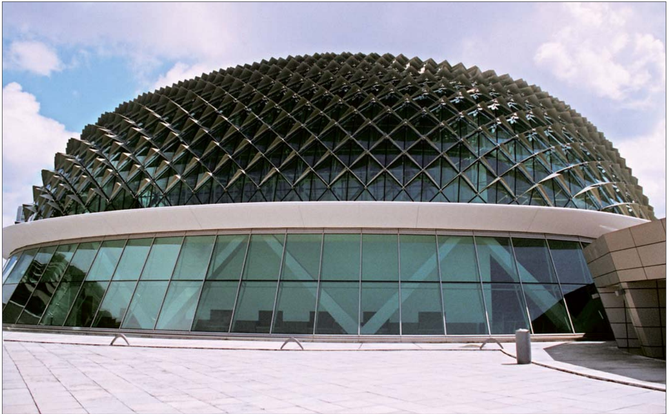
Mit TIGER Pulverlack beschichtete Fassadenelemente, wie hier verzinkte Stahlbauteile auf dem Kuppeldach des Esplanade Arts Center in Singapur, sind rund um den Globus zu finden.
