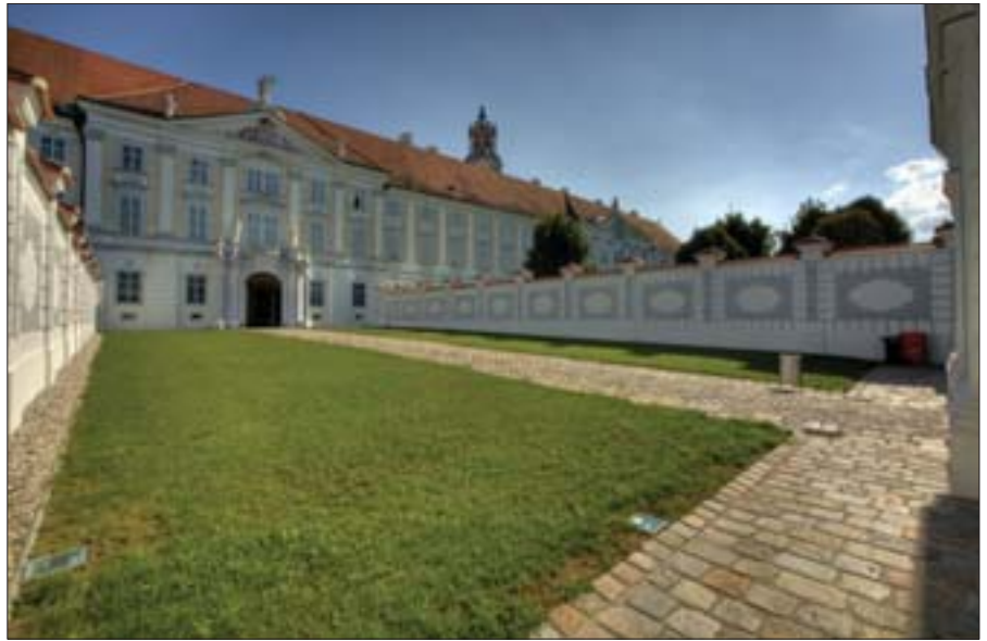
Die Gestaltung des Vorwerks stammt von Joseph Munggenast. Die noble Färbelung in weiß und grau und die davor liegende Platzgestaltung lassen den Vorbau in richtiger Weise zur Geltung kommen.
