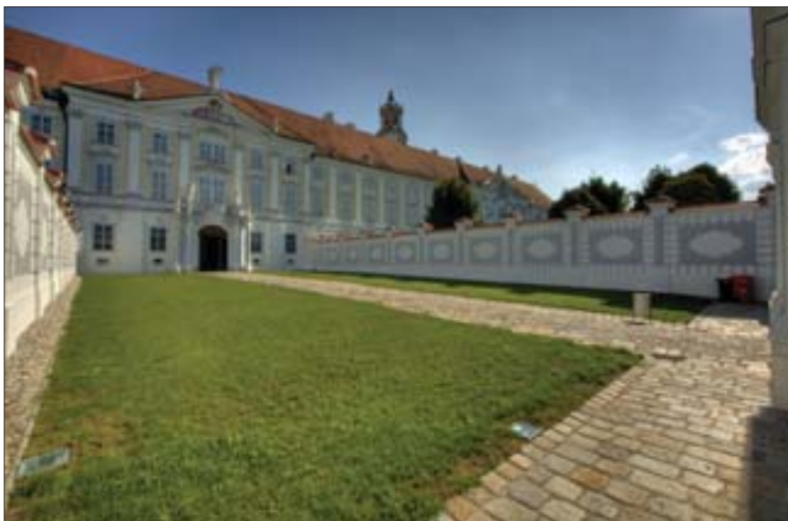
Die Gestaltung des Vorwerks stammt von Joseph Munggenast. Die noble Färbelung in weiß und grau und die davor liegende Platzgestaltung lassen den Vorbau in richtiger Weise zur Geltung kommen.
