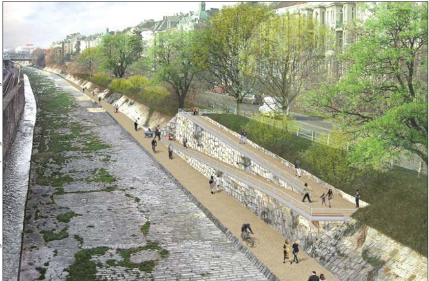
»Wiental Highway« vom Hackingersteg bis zur Pilgrambrücke
