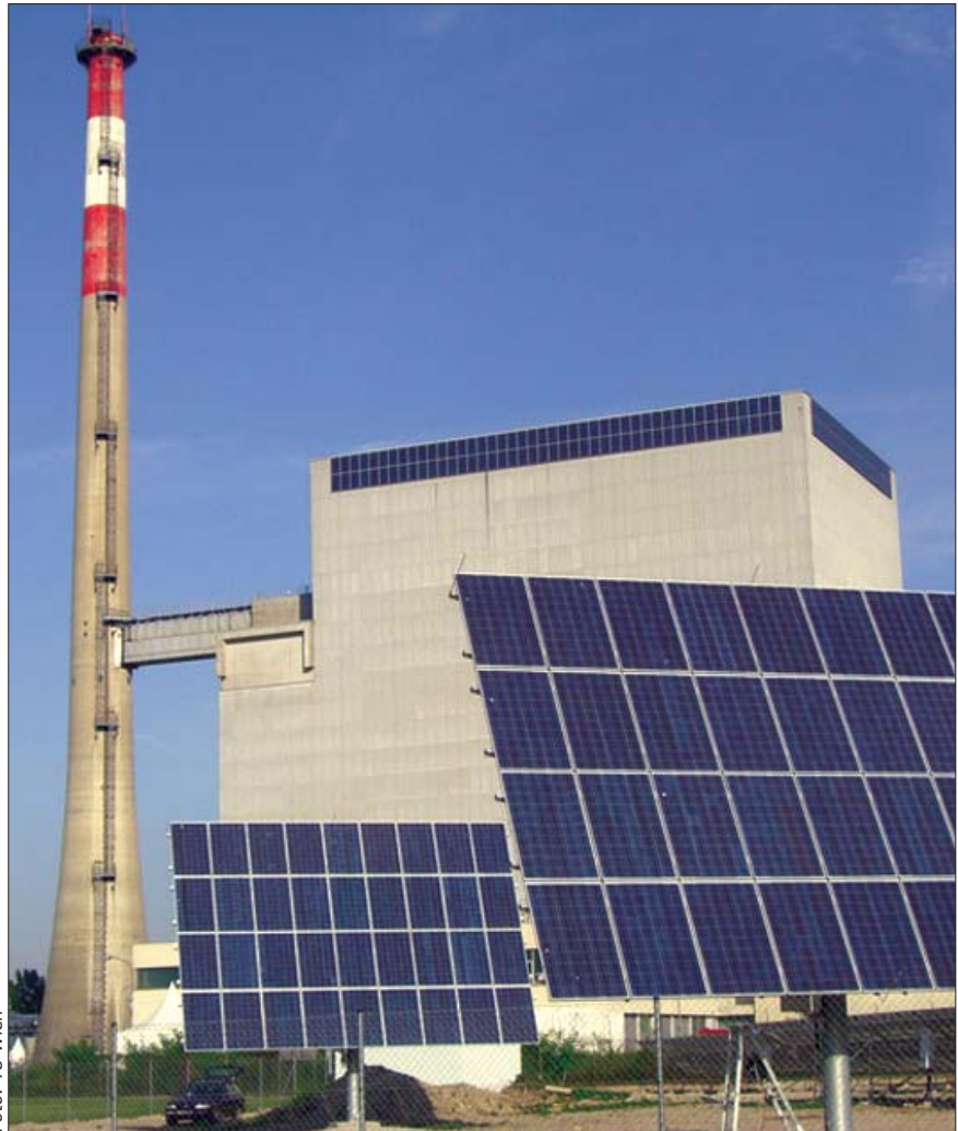
Photovoltaikmodule mit solarem Nachführungssystem (Sun-Tracker)
