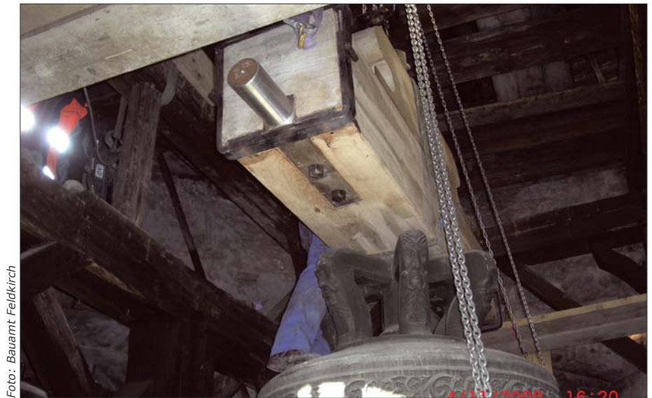
Das neue Joch – die Aufhängung der Glocke – wird eingepaßt.
