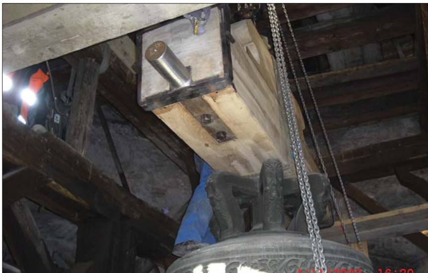
Das neue Joch – die Aufhängung der Glocke – wird eingepaßt.
