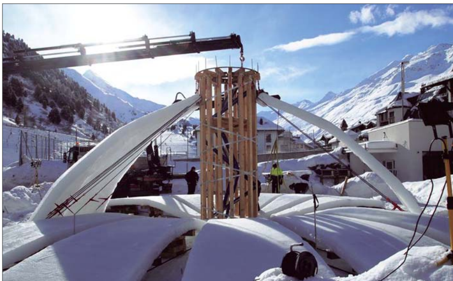
Die Eiskuppel wird errichtet – zunächst mit Hilfe eines stützenden Holzturmes.
