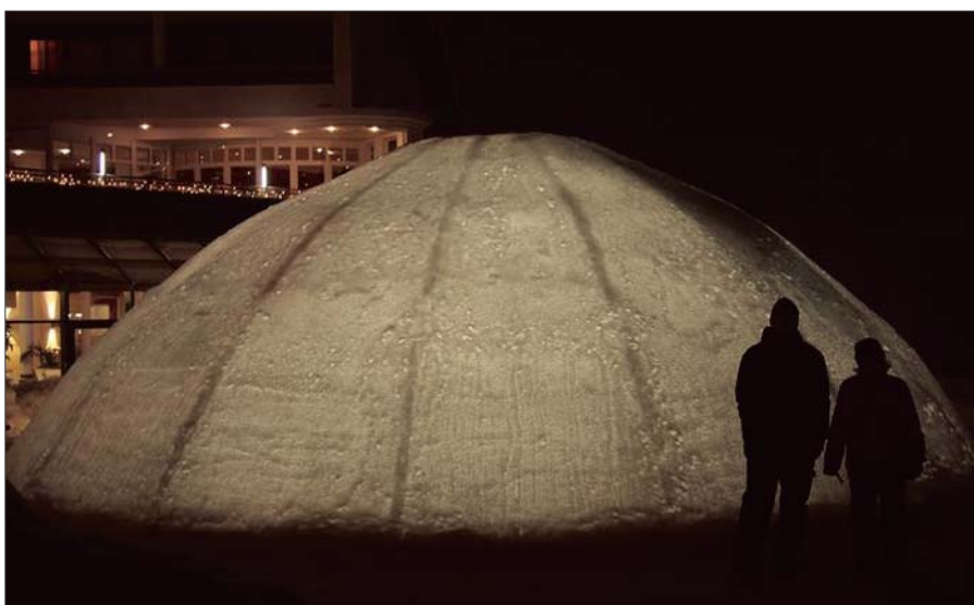
Die Eiskuppel, von innen beleuchtet.
