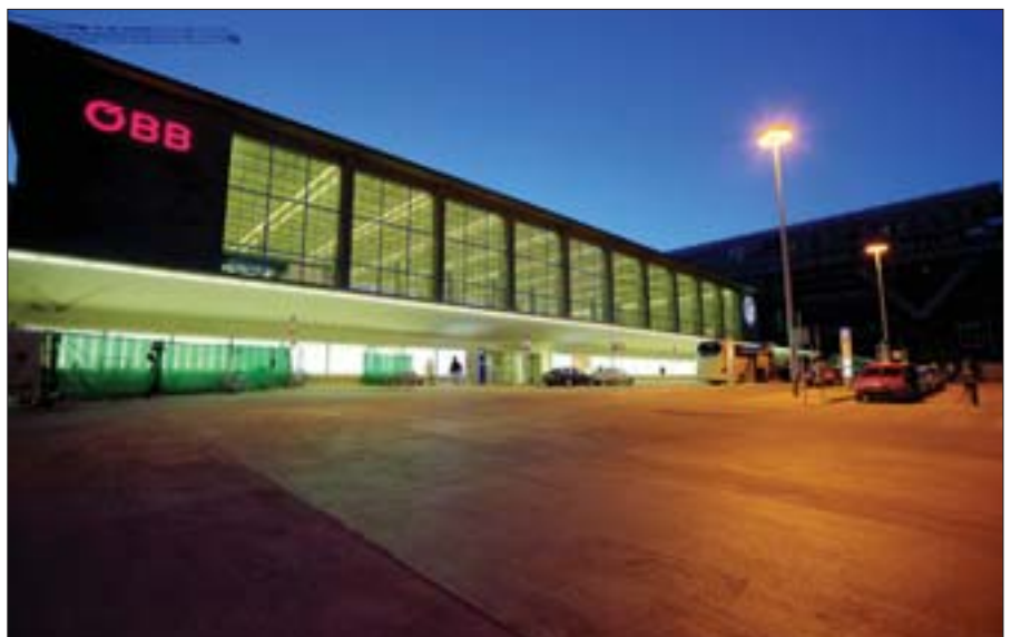
Der neue Vorplatz des Westbahnhofs
