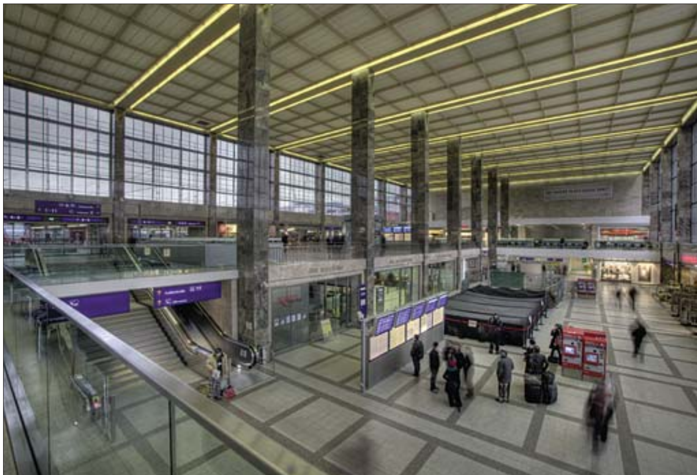
Der Umbau der dermalgeschützten Bahnhofshalle erfolgte in enger Abstimmung mit dem Bundesdenkmalamt.
