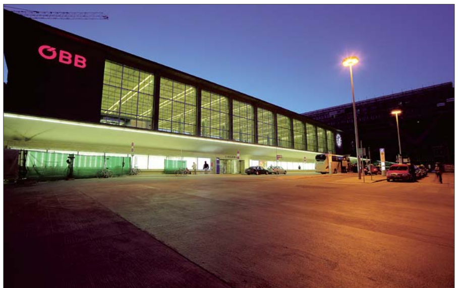
Der neue Vorplatz des Westbahnhofs
