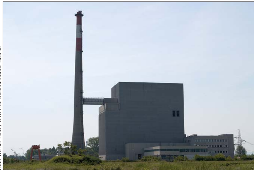
Das nie in Betrieb gegangene Atomkraftwerk Zwentendorf hat insgesamt 14 Milliarden Schilling gekostet, 600 davon die Konservierung. Heute ist es ein Museum.
