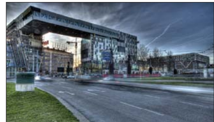
Zügiger Umbau des Westbahnhofs S 74
