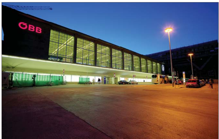
Der neue Vorplatz des Westbahnhofs
