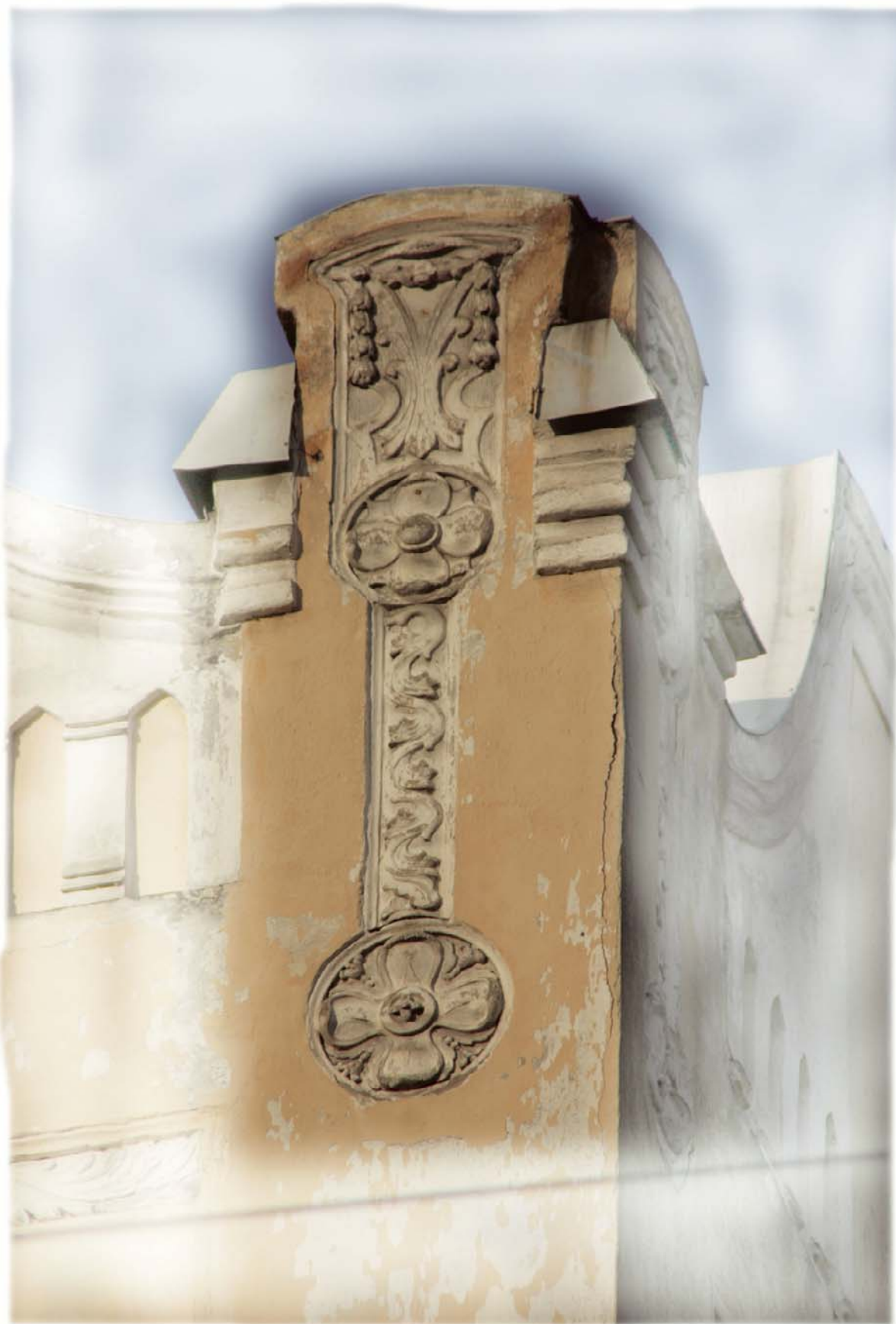
Dachaufsatz auf einem Wohnhaus in Cluj
