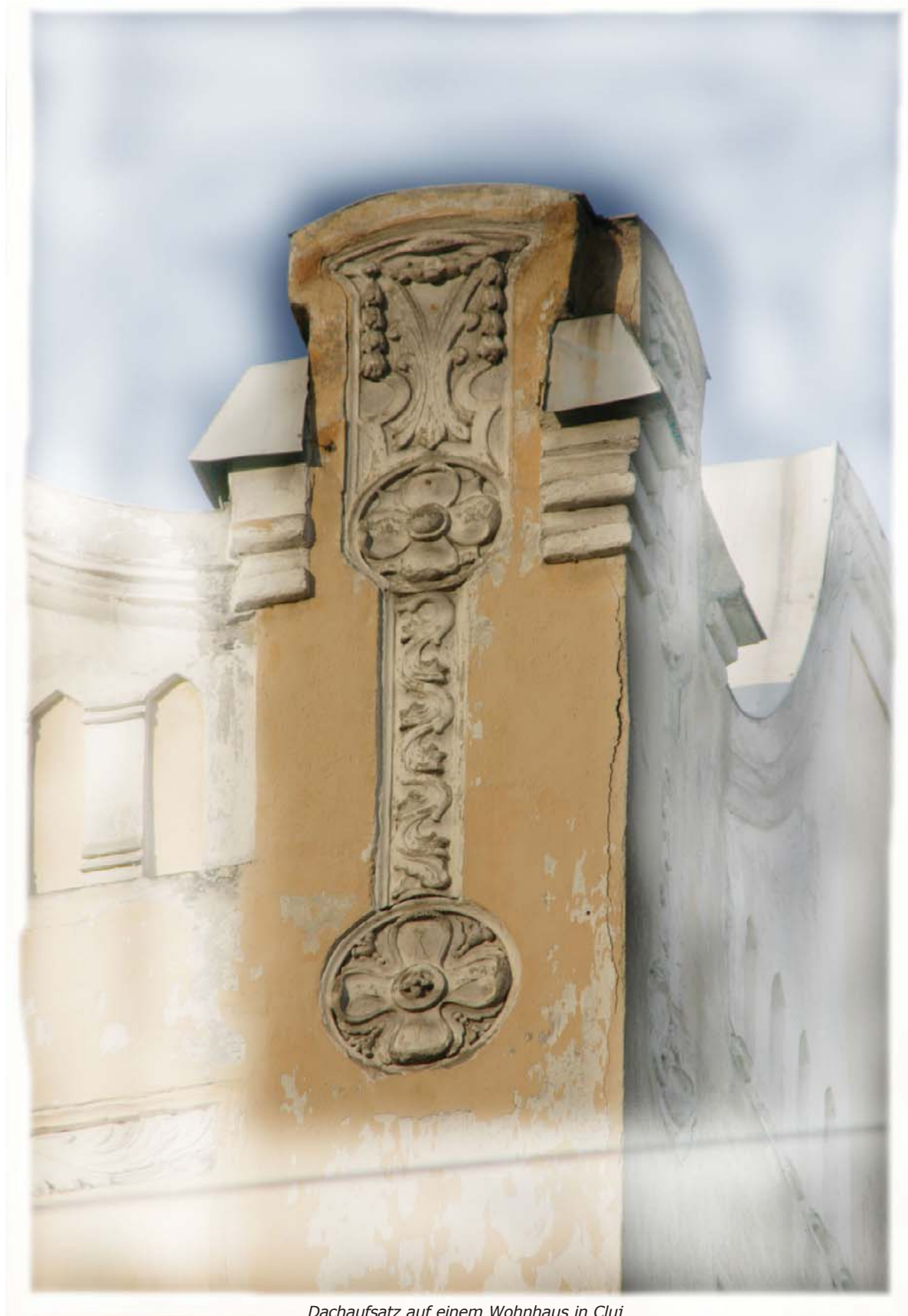
Dachaufsatz auf einem Wohnhaus in Cluj
