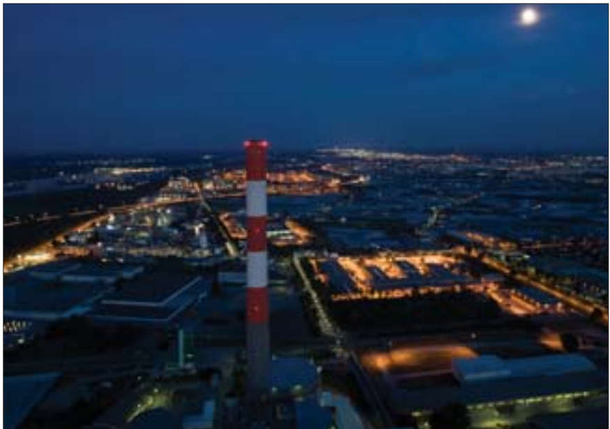
Foto: Wiener Stadtwerke
