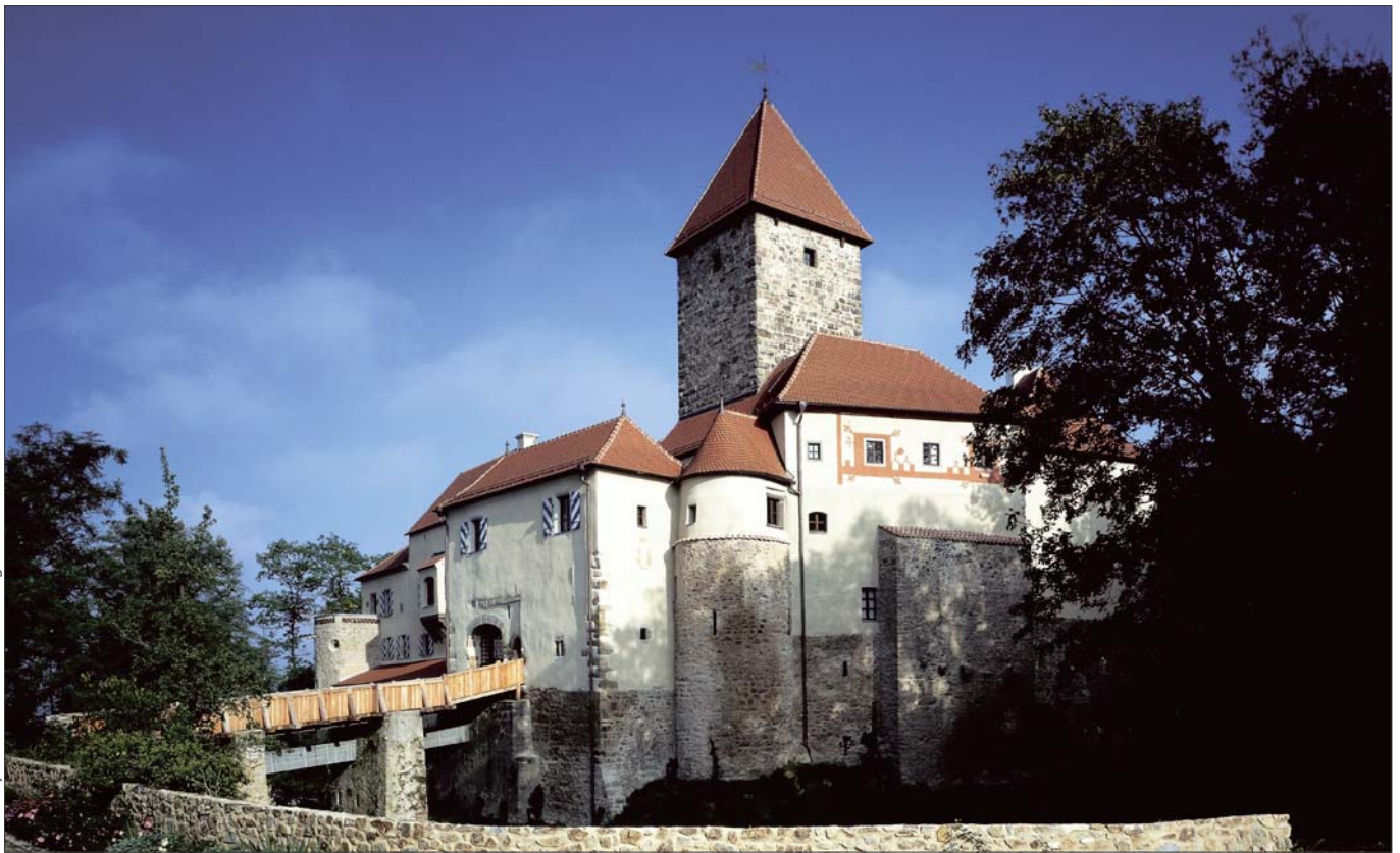
In der imposanten Burg Wernberg im Oberpfälzer Wald gaben sich bereits im 12. Jhdt. Burgfräulein und Ritter das Ja-Wort.
