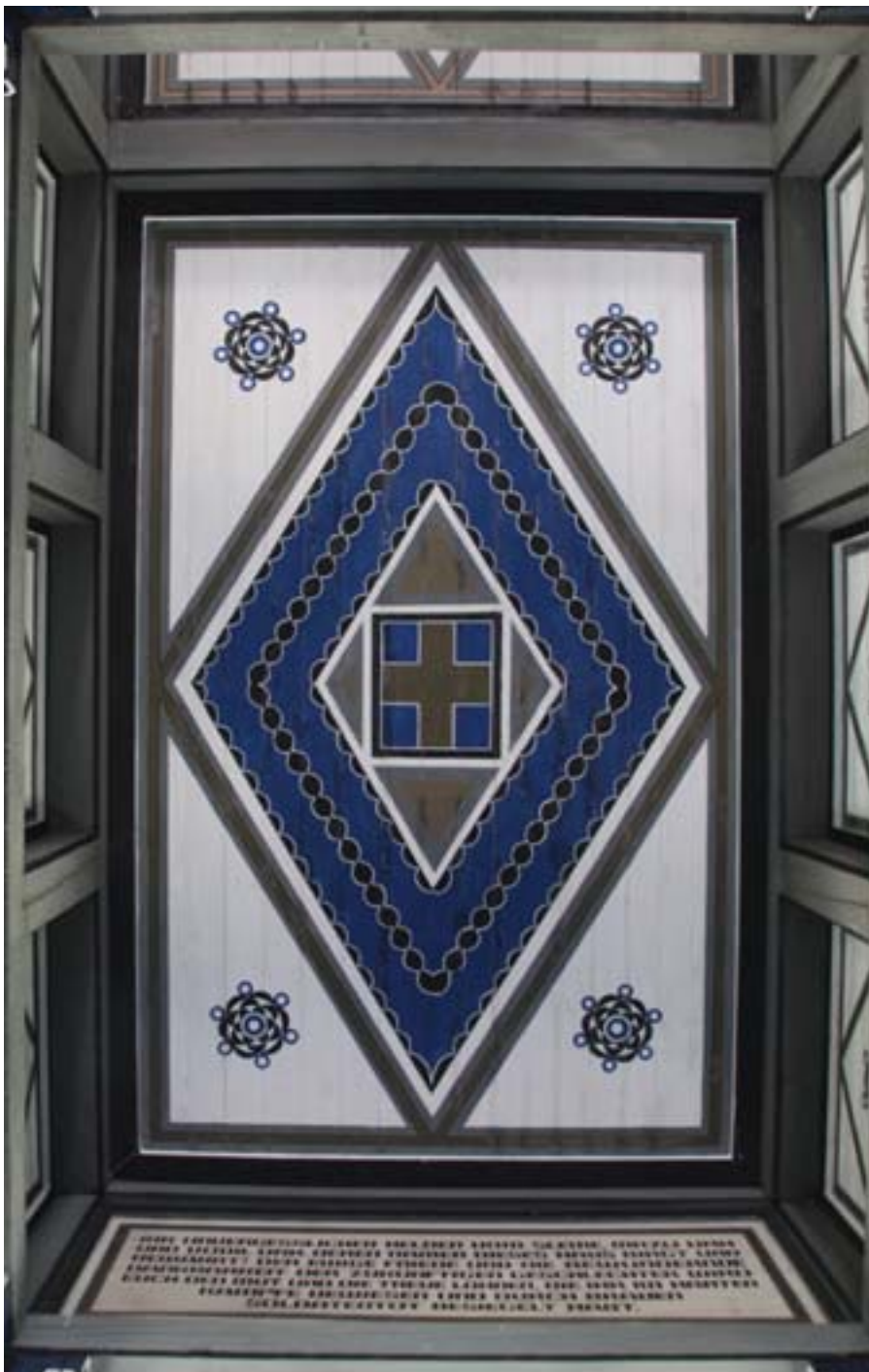
Decke des Mittelschiffes
