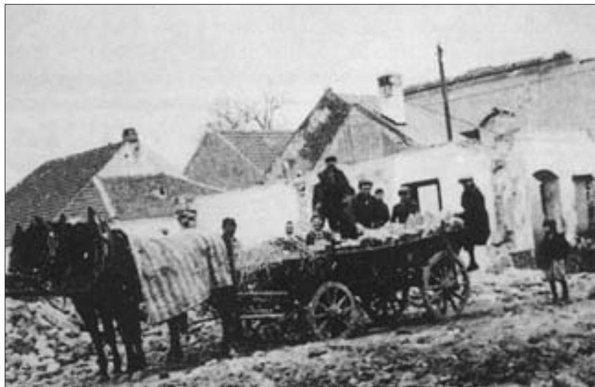
Abbruch der Synagoge in Frauenkirchen an Jahr 1938
