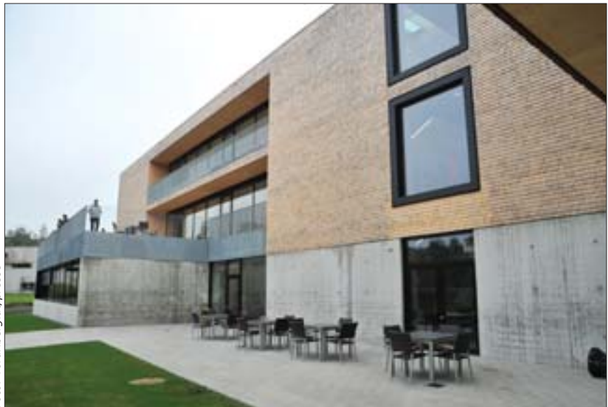
Das neue Sozialzentrum ist im Passivhausstandard errichtet worden
