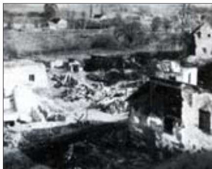
Bombenschäden in Güssing
