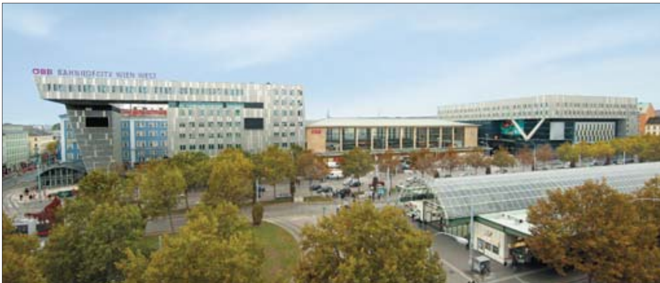
Außenansicht BahnhofCity Wien West: Der »alte«, denkmalgeschützte Westbahnhof wird von den neuen Komplexen flankiert.
