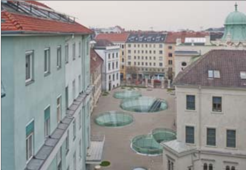
Die architektonische Gestaltung des Joanneumsviertels räumt den historischen Gebäuden den ihnen gebührenden Stellenwert ein.
