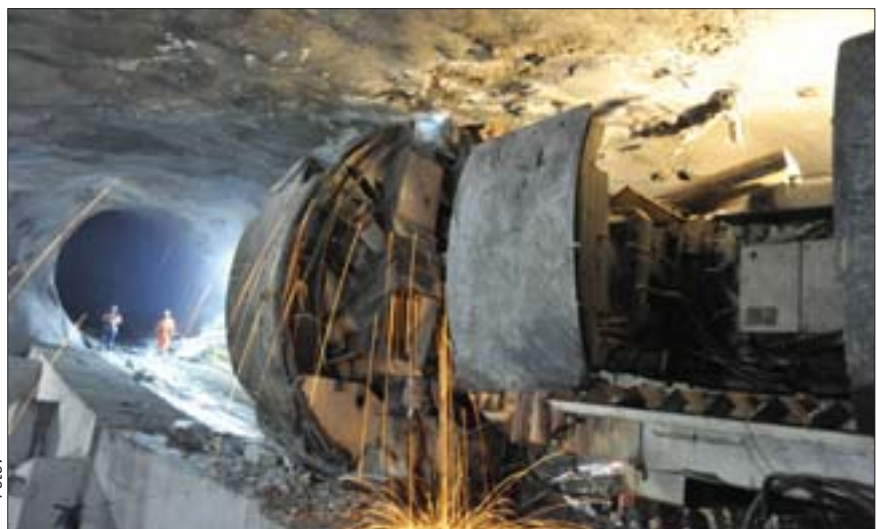
Diese beiden Baustellenfotos geben einen kleinen Überblick über die nahezu unvorstellbaren Dimensionen dieses Projektes. Im Bild unten sieht man eine Stollenfräse im Schrägschacht bei den Bauarbeiten zu Limberg II in Kaprun.
