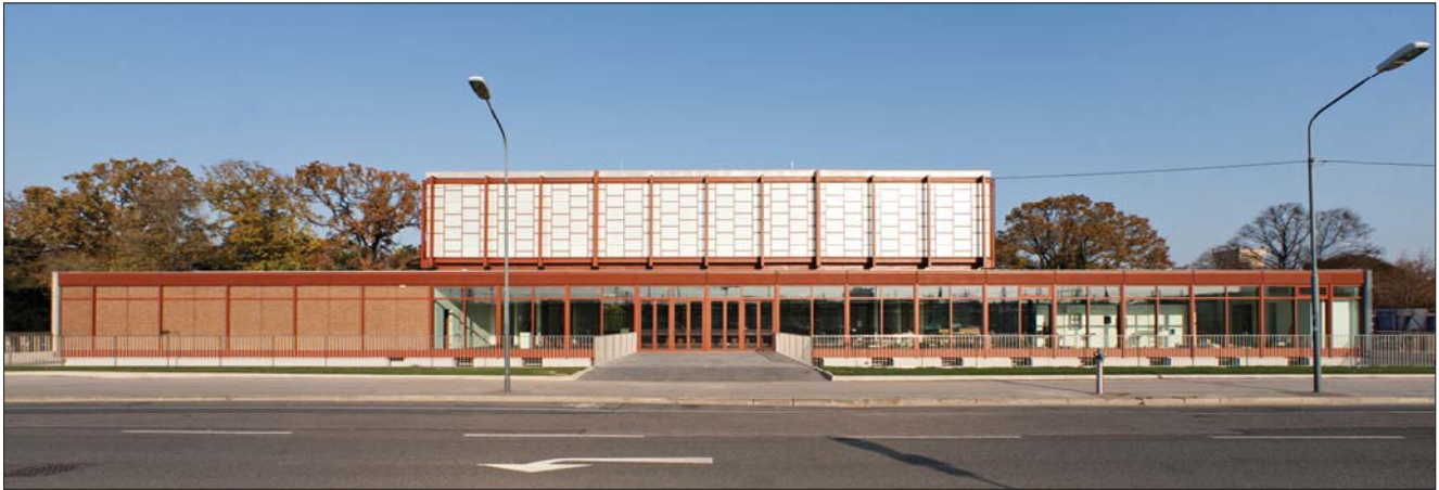
Das 21er Haus am Rande des Schweizergartens und gegenüber dem künftigen »Wien Hauptbahnhof – Europa Mitte«
