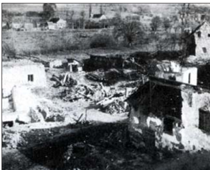
Bombenschäden in Güssing
