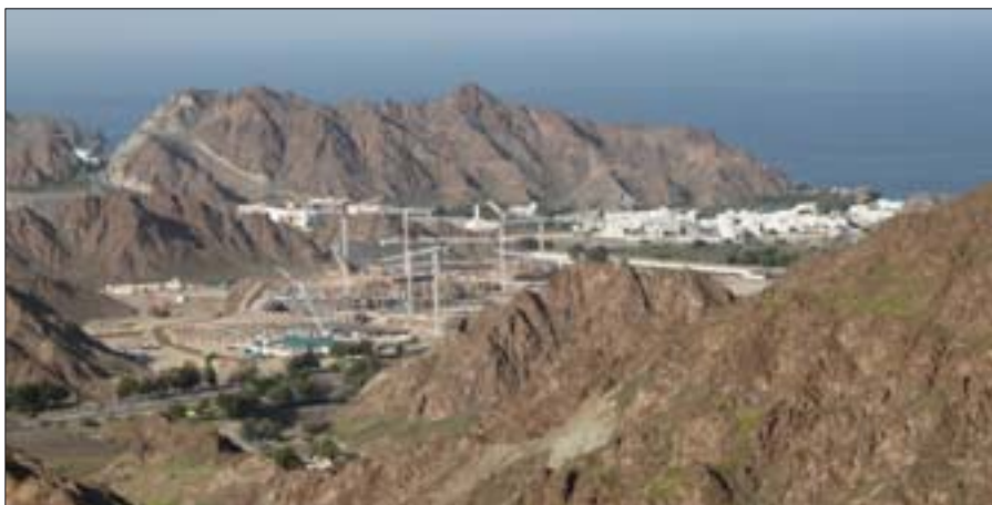
Gebaut wird im Oman eifrig – hier soll ein Parlamentsgebäude entstehen.
