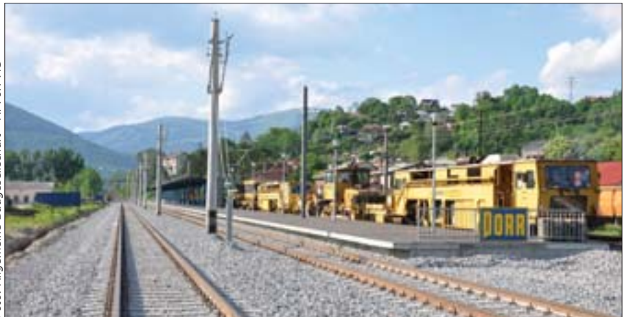
Foto: Allgemeine Baugesellschaft - A. Porr AG
