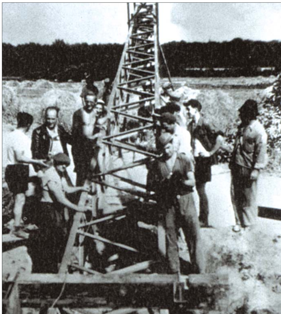
Stromversorgung Anfang der 50er Jahre
