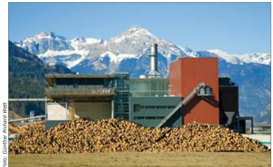
Architekt H. Reitter: Biomasse-Kraftwerk »Feuerwerk Binder« im Tiroler Zillertal
