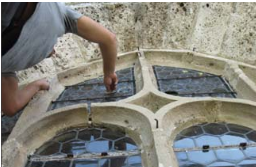
Restauratorische Maßnahmen: Glasfenster, Windeisen und Schutzgitter
