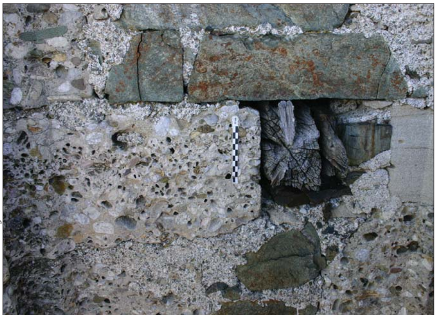
Bestandserfassung 2010: Kantholz in einem offenen Gerüstloch vom bauzeitlichen Auslegergerüst
