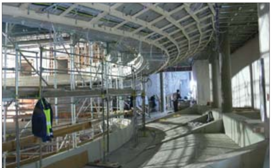
1. Rang hinten, Blick nach Süd. Die Unterkonstruktion für die Deckenuntersicht ist fertiggestellt. Hinten im 2. Rang die Resonatoren der Südseite.
