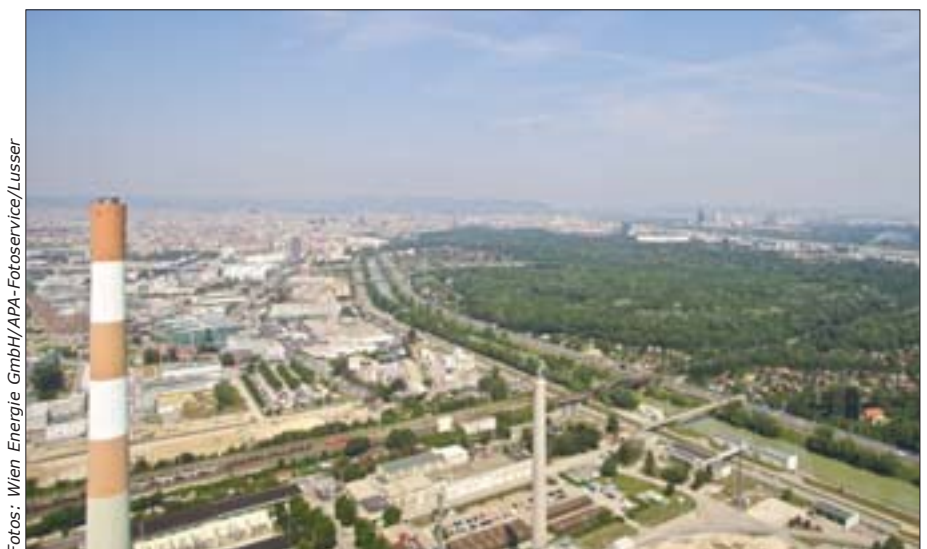
Luftaufnahme des Areals, wo der 1. Hochdruck-Wärmespeicher gebaut wird
