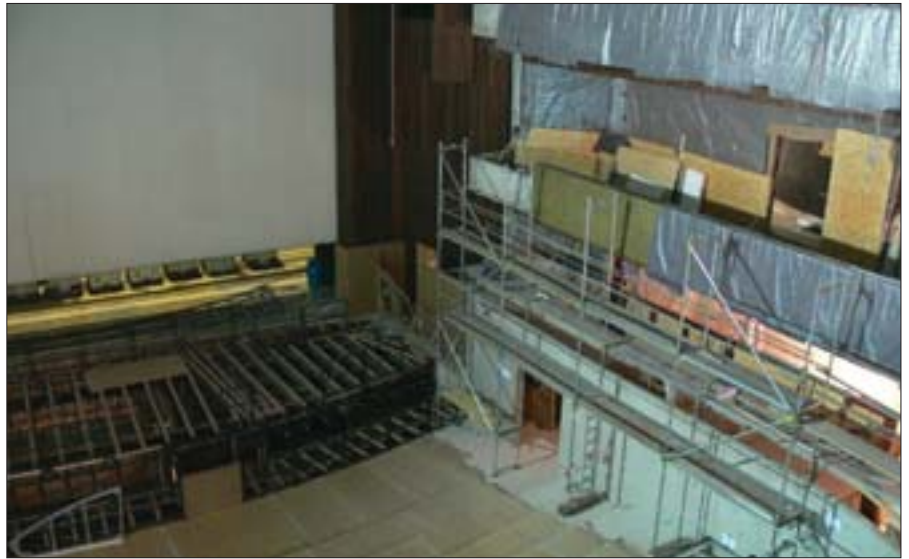
Die Ausgestaltung der Brüstungen der Zuschauerränge des Großen Saals in gold-optischer Echtmetallbeschichtung ist sehr weit fortgeschritten.
