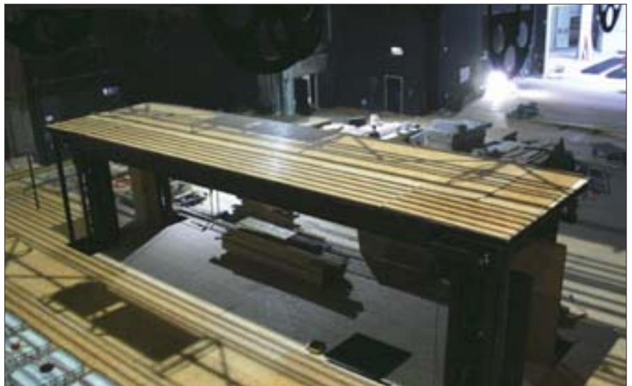
Blick auf die Bühne: Das hinterste der drei Hubpodien ist aus der Bühnenebene hochgefahren. Gut erkennbar die Doppelstockeinrichtung dieser Bühne.
