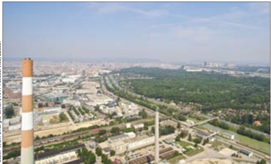
Luftraufnahme des Areals, wo der 1. Hochdruck-Wärmespeicher gebaut wird
