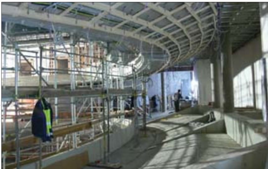
1.Rang hinten, Blick nach Süd. Die Unterkonstruktion für die Deckenuntersicht ist fertiggestellt. Hinten im 2.Rang die Resonatoren der Südseite.
