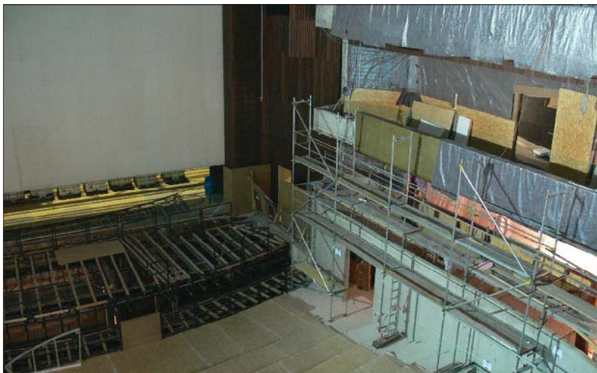
Die Ausgestaltung der Brüstungen der Zuschauerränge des Großen Saals in gold-optischer Echtmetallbeschichtung ist sehr weit fortgeschritten.
