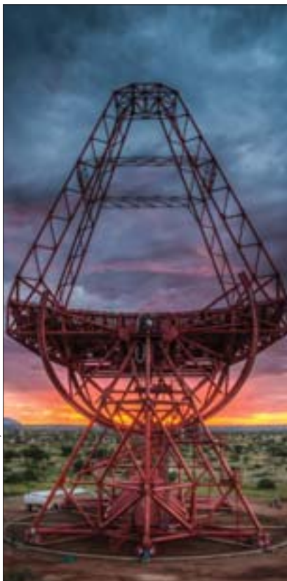
Die H.E.S.S.-Stahlkonstruktion vor dem Einbau der Kamera an einem ungewöhnlich bewölkten Tag
