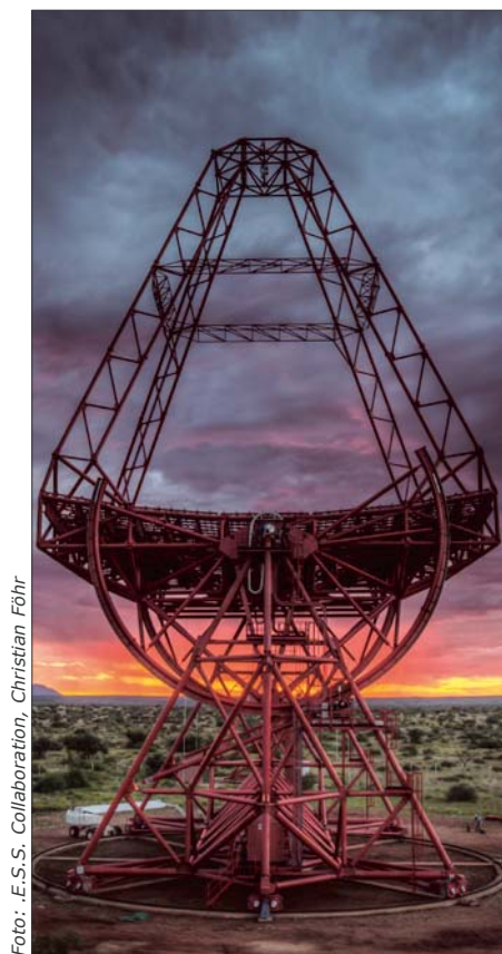
Die H.E.S.S.-Stahlkonstruktion vor dem Einbau der Kamera an einem ungewöhnlich bewölkten Tag
