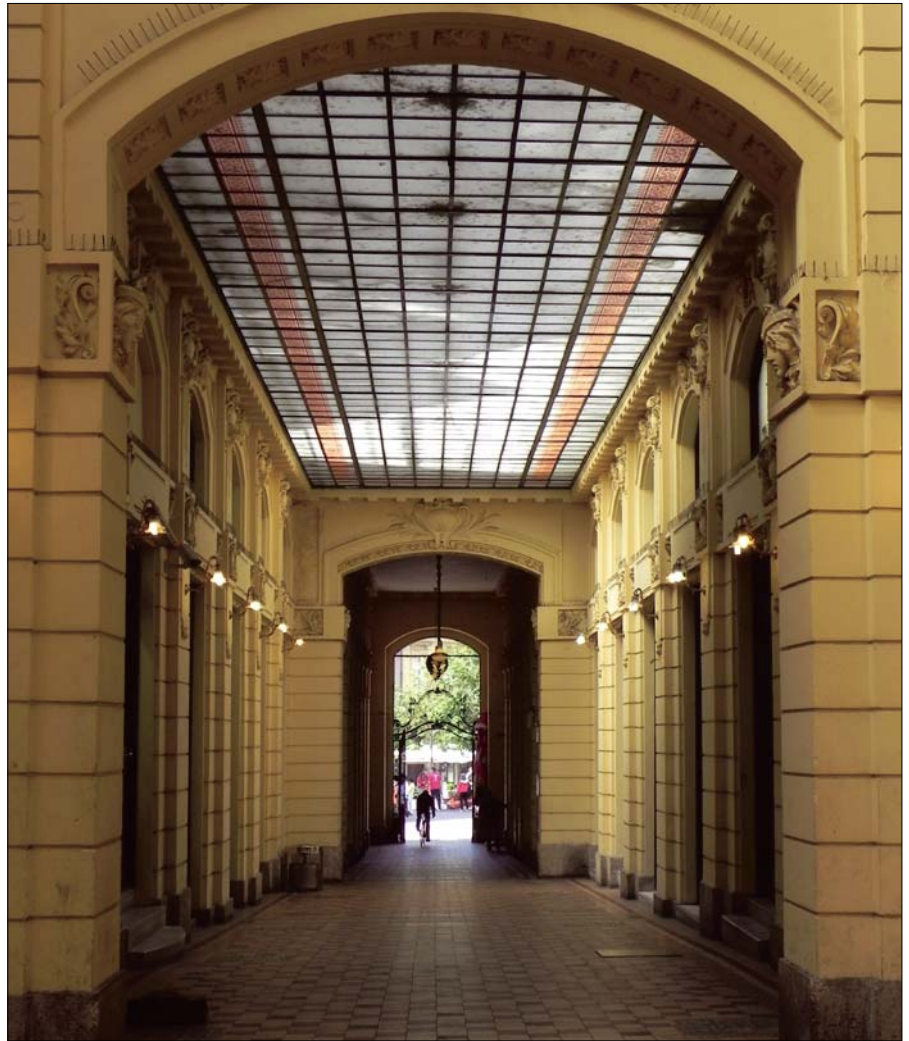
»Oktogon« – der erste überdachte Durchgang im Haus der ehemaligen Ersten kroatischen Sparkasse, dessen Zentrum mit einer Glaskuppel überbaut und in der Form eines Achteckes gegliedert ist. Das Gebäude wurde im Stil des Historismus 1901 vom kroatischen Adligen Josip pl Vancas geplant.
