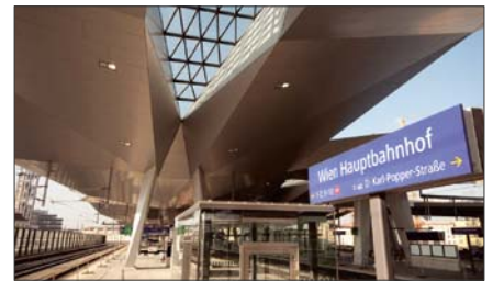
Teilbetriebnahme Hauptbahnhof Wien S 47
