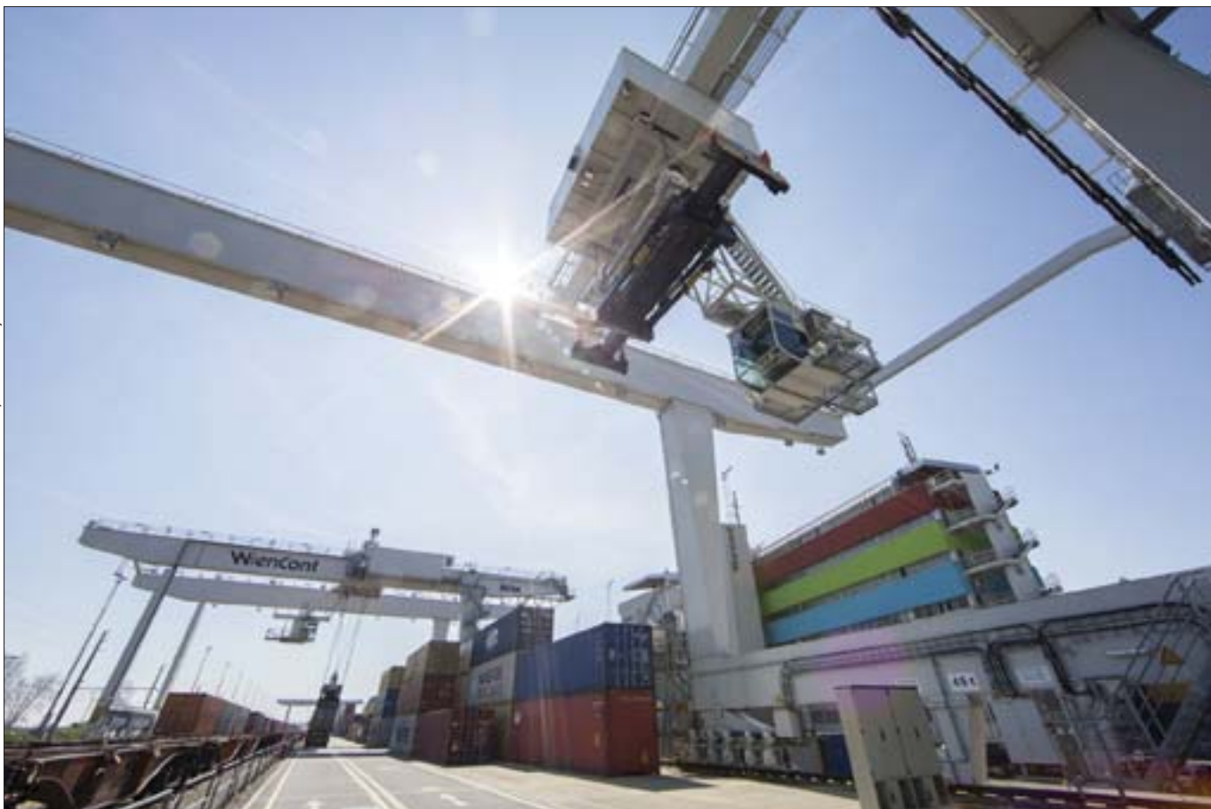
Die neue Kranbrücke ist insgesamt 24,5 Meter hoch und 30,5 Meter breit. Der Stahlriese kommt auf ein Eigengewicht von 315 Tonnen. Die Spannweite des Hauptträgers der Kranbrücke beträgt 54,6 Meter.
