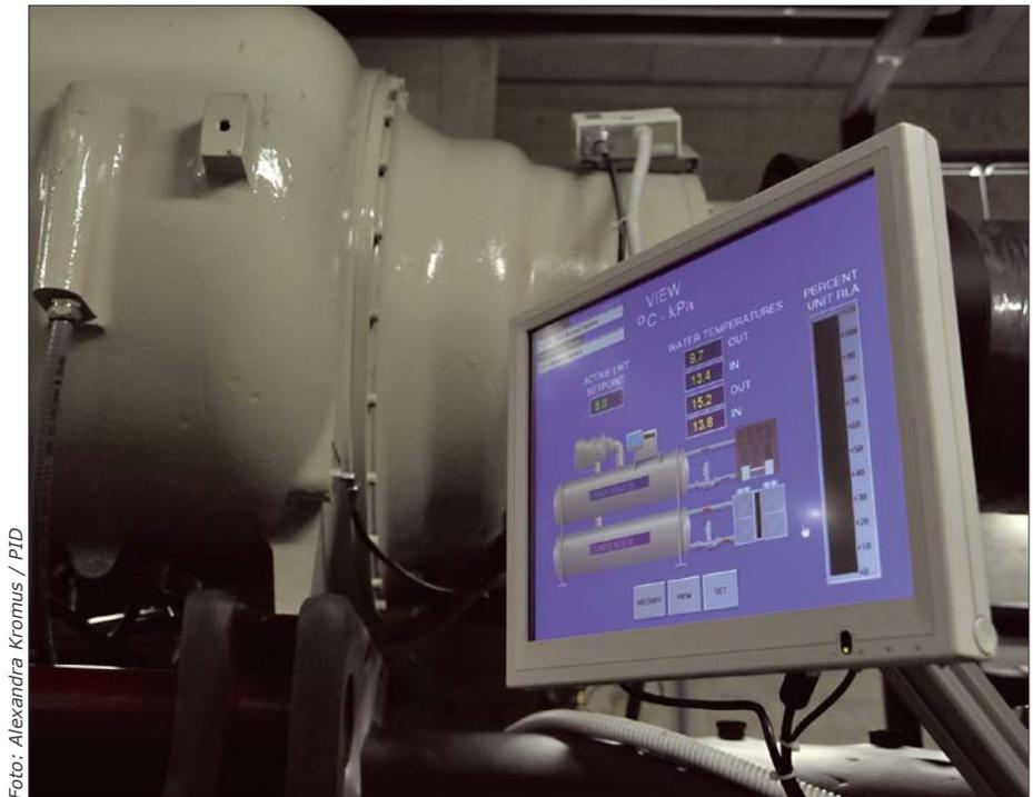
Ein Blick ins Innere des »Kühlschranks«: Eines der Aggregate, Vordergrund die Visualisierung des Ist-Zustandes mit Angabe von Temperatur, Leitungsdruck usw.
