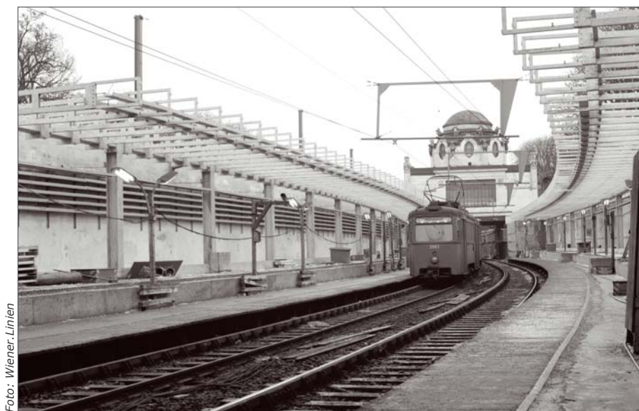
Stadtbahn mit Zug der Type N1-n1 Station Hietzing, Schönbrunn, um 1980
