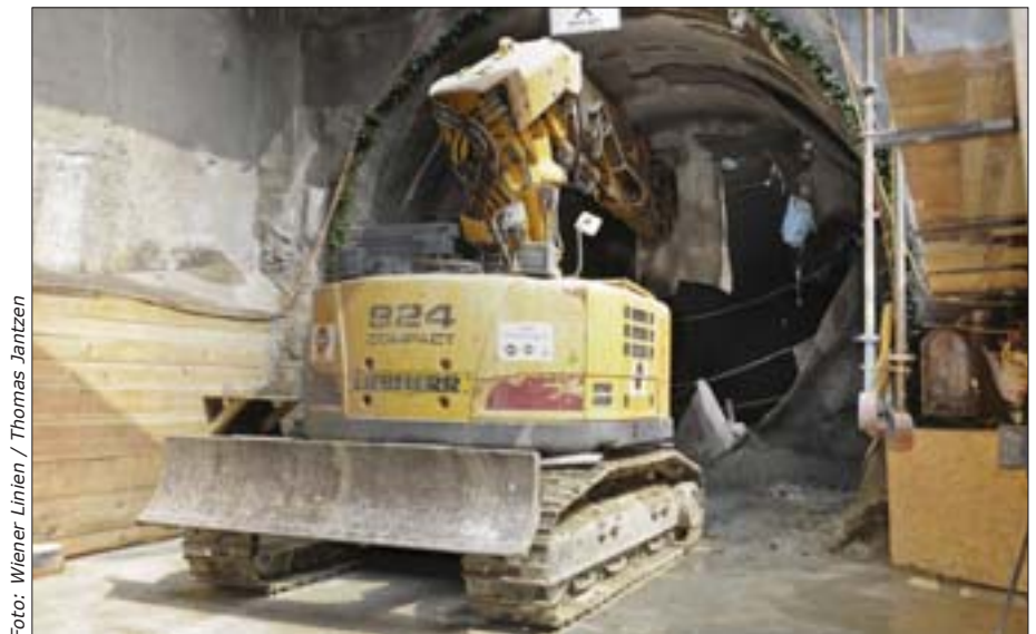
Bagger beim Durchstich bei der künftigen U1-Station Alaudagasse m 10. Bezirk
