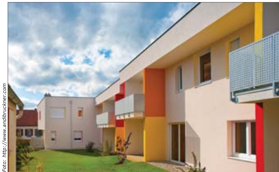
In einem neuen Wohnprojekt der Oberwarther Siedlungsgenossenschaft OSG sind in der Gemeinde Pilgersdorf sowohl Kleinwohnungen für Senioren, Kleinwohnungen als Startwohnungen für junge Menschen als auch Familienwohnungen entstanden.
