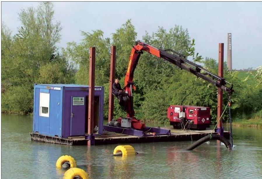
Eine aufwendige Eigenentwicklung: Schwimmkran mit Hydraulikfräse, mit dem Teichentschlammungen und Entlandungen an Kraftwerken durchgeführt werden.
