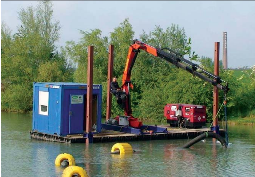
Eine aufwendige Eigenentwicklung: Schwimmkran mit Hydraulikfräse, mit dem Teichentschlammungen und Entlandungen an Kraftwerken durchgeführt werden.
