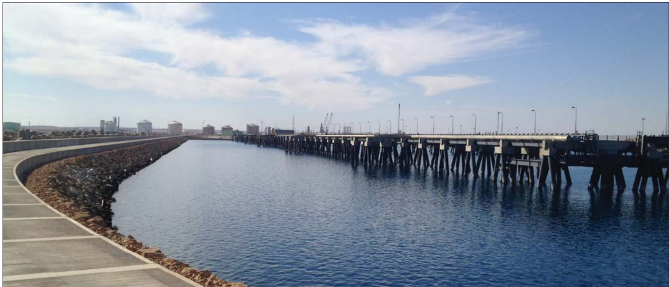
Aktuellster Einsatzort der Bautaucher aus Wolfsegg: die Hafenanlage einer der wichtigsten Raffinerien Libyens. Große Gefahr droht hier nicht nur durch durch Schußwechsel, sondern auch durch nicht detonierte Kriegsrelikte und Munitionsreste...
