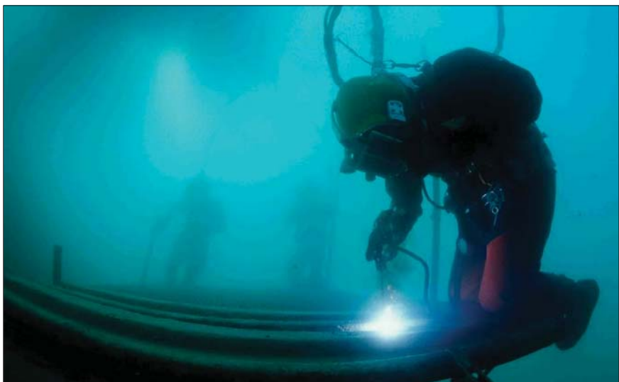
Schweißarbeiten unter Wasser sind für Laien kaum vorstellbar.
