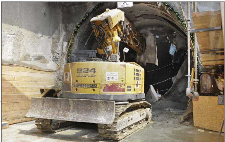
Bagger beim Durchstich bei der künftigen U1-Station Alaudagasse m 10. Bezirk
