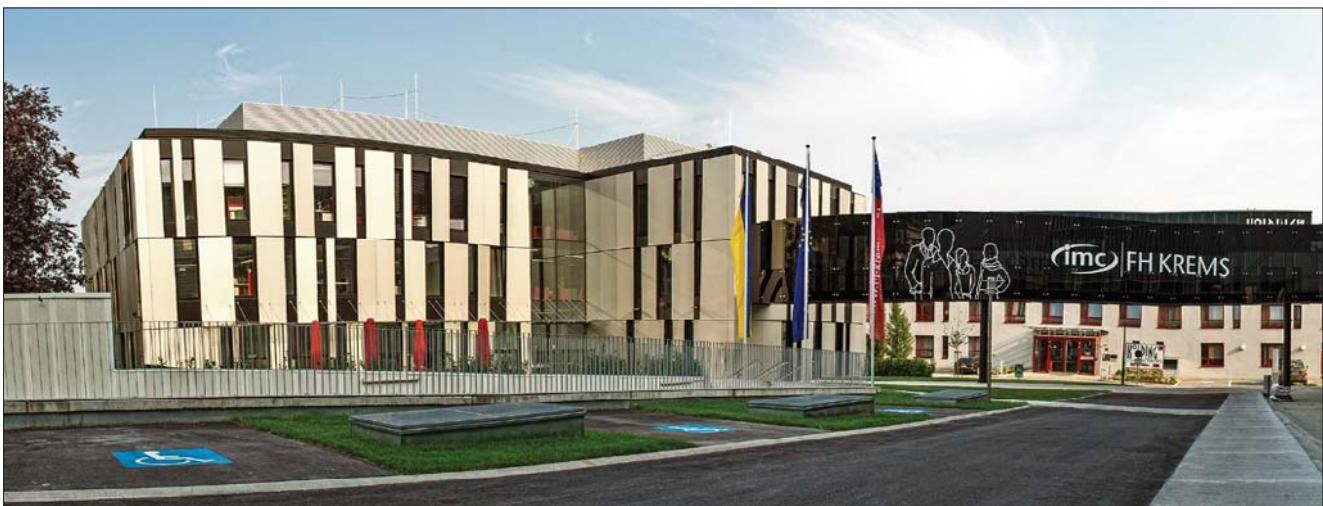
Mit der Erweiterung des Standortes »Am Campus KREMS« kann allen studentischen Anforderungen entsprochen werden: Platzangebot und Infrastruktur genügen höchsten Standards...
