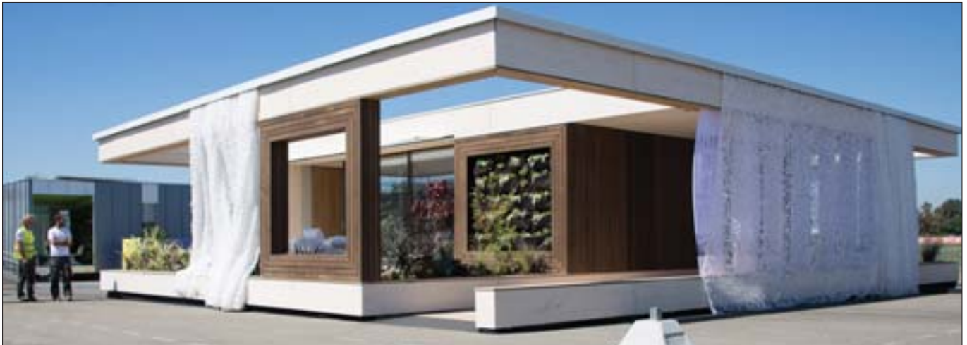
Bei sonnigem kalifornischen Wetter kann man die Glasfassaden verschwinden lassen, Veranda und Innenwohnraum fügen sich dann nahtlos zu einem großen teilüberdachten Wohnbereich zusammen. Nicht nur das hat die JurorInnen begeistert,
