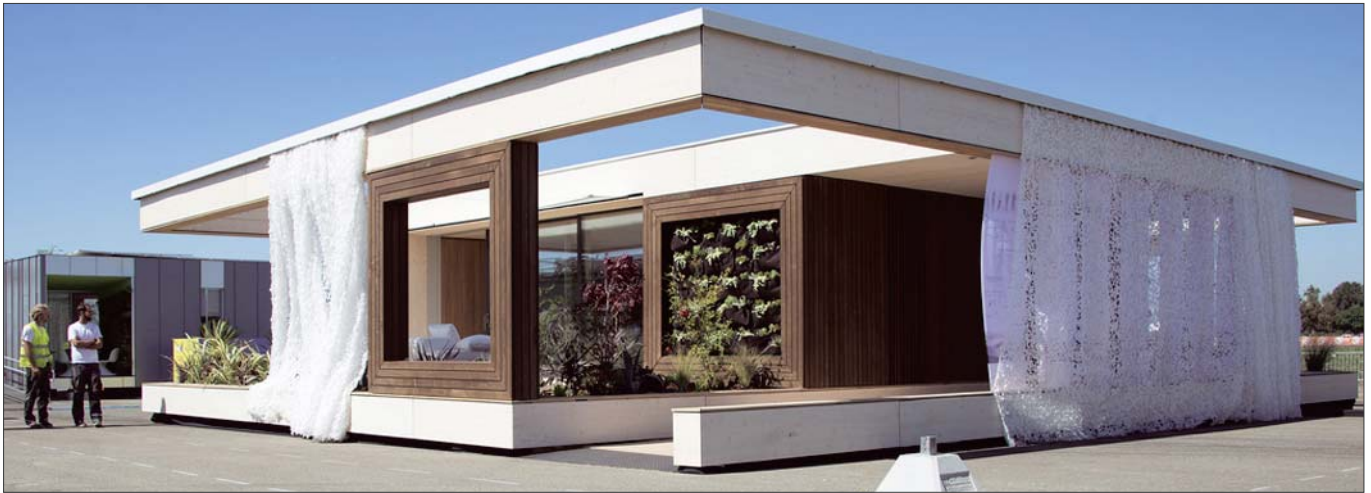
Bei sonnigem kalifornischen Wetter kann man die Glasfassaden verschwinden lassen, Veranda und Innenwohnraum fügen sich dann nahtlos zu einem großen teilüberdachten Wohnbereich zusammen. Nicht nur das hat die JurorInnen begeistert,
