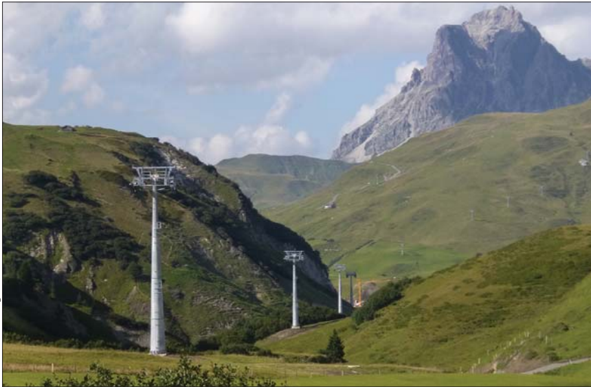
Die Trasse des Auenfeldjets: Musterbeispiel für eine sanfte, schonende Bauweise.
