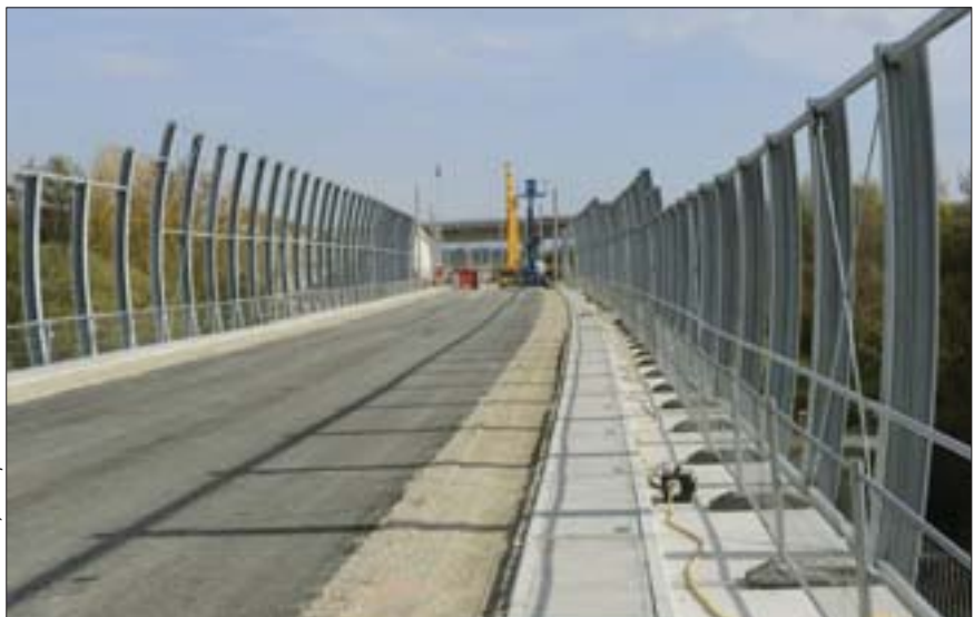
Die Trasse auf der neuen Draubücke bei Stein
