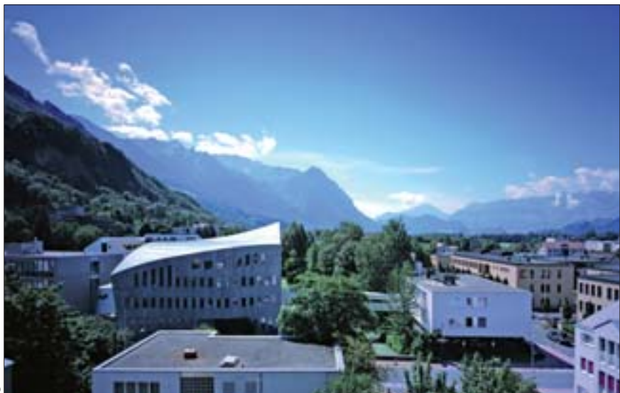
Bankgebäude Centrum Bank, Vaduz, Liechtenstein, 1999-2002
