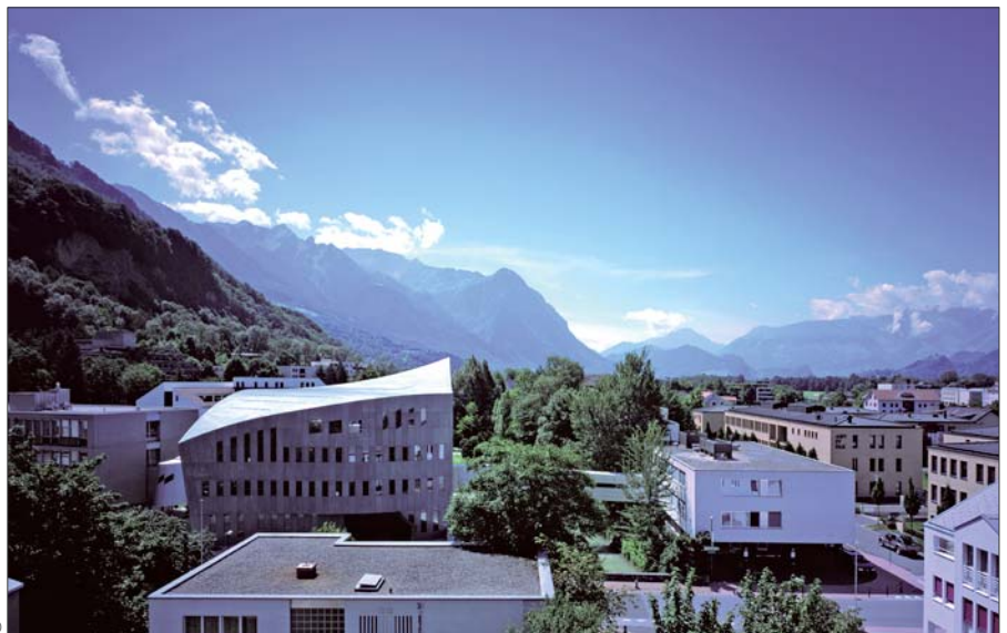
Bankgebäude Centrum Bank, Vaduz, Liechtenstein, 1999-2002
