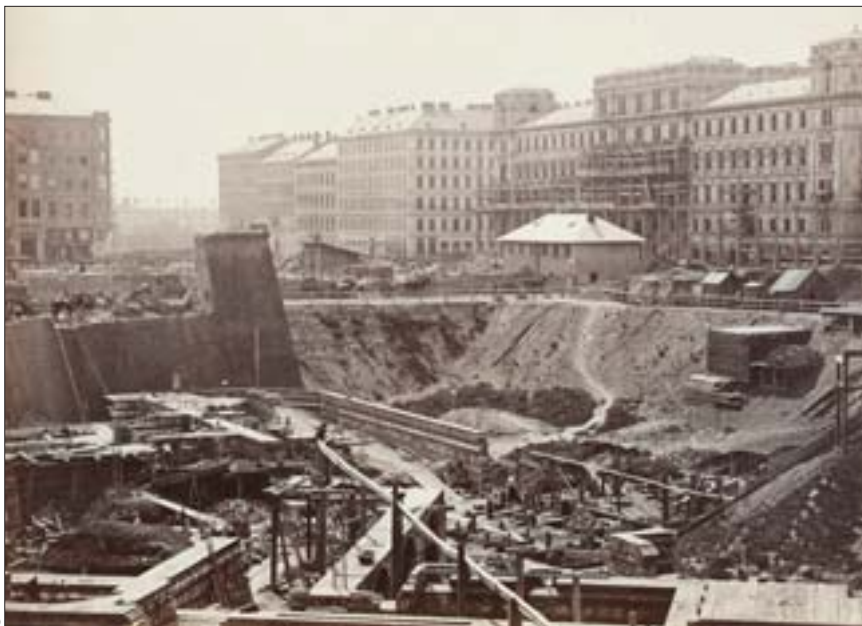
Ringstraßenbaustelle mit Heinrichshof, um 1863, Fotografie
