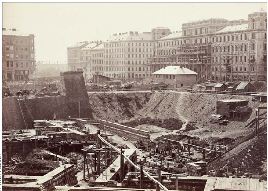
Ringstraenbaustelle mit Heinrichshof, um 1863, Fotografie
